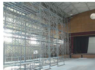
ステージ足場
