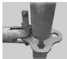
③クサビをハンマーで打ち込みフランジに確実に固定させます。
