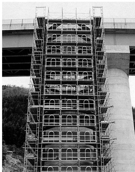
日本道路公園山形自動車道北川橋
