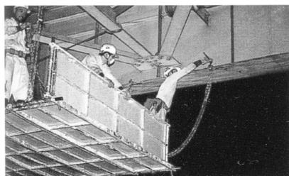
パネルを前方に押し出し、パネルの凹穴に1枚目の「直線・両用連結ジョイント」を差し込みます。次に「脱落防止ピン」を差し込み、「ジョイント固定ボルト」を締め付けます。
