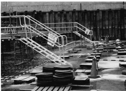
安全通路より作業床面への昇降設備
