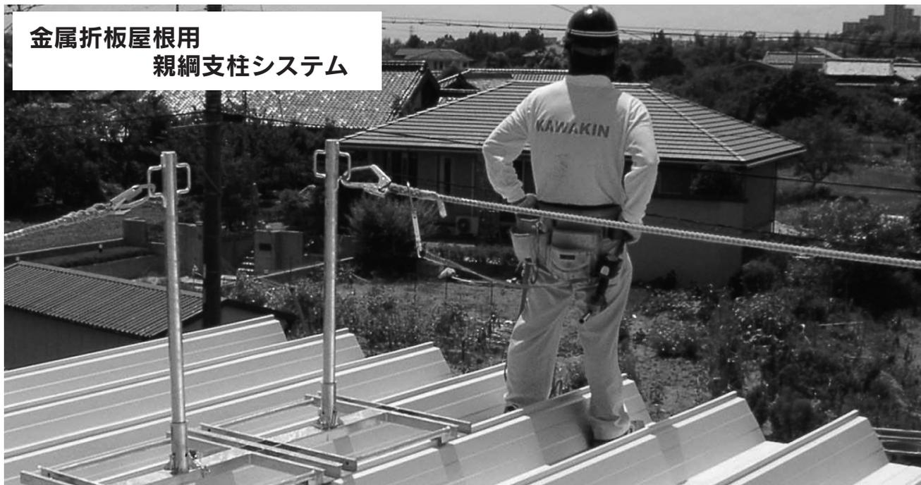
ショッピングセンター、倉庫など大空間建築物に多く採用されるハゼ締めタイプの金属製長尺折板屋根。その屋根の軒先、ケラバ、開口部からの墜落・転落を防ぐ安全帯取付設備の親綱システムです。
