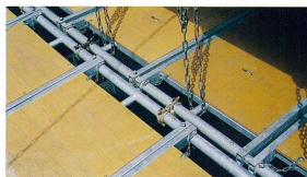
コンパネパネル使用時の作業床
