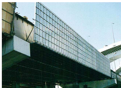
吊足場の側面に使用した例
