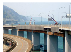
施工例 (北陸道親不知 試験施工)
