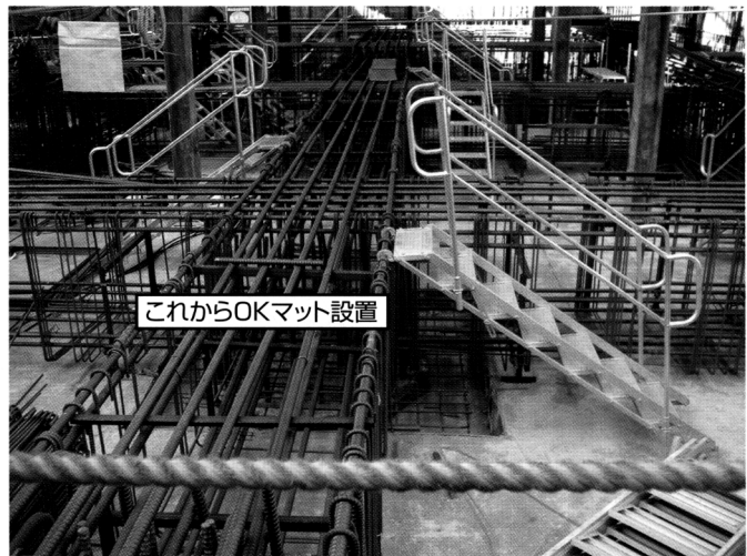
地中梁鉄筋を乗り越える為の使用
