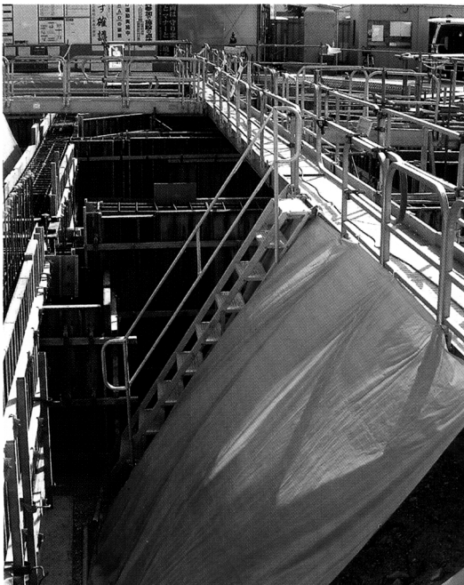
安全通路より作業床面への昇降設備
