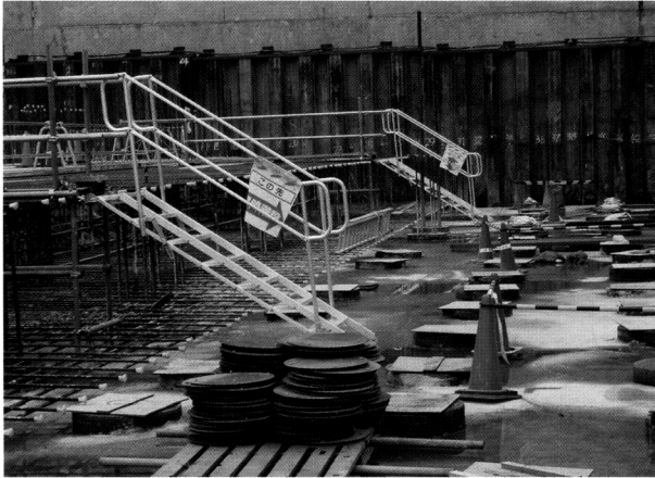
地足場より作業場への昇降設備
