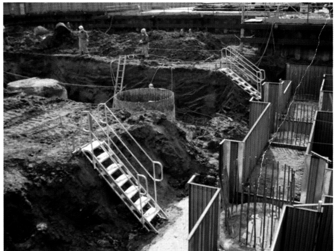
基礎工事の時の昇降設備
