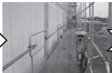
養生骨組み取付け
