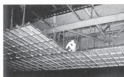
2列目(横断方向)を設置する場合、順次1列目と2列目のパネルを自在クランプで連結します。また、1列目と2列目のパネルとの隙間(チェーン回り)をSKプレートで防護します。
