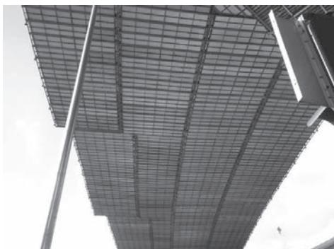
セーフティSKパネルは、パネル型の作業床をチェーンで吊り、連結して行くと吊り足場が完成する、極めてシンプルな新しい吊り足場工法です。
