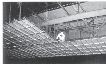
2列目(横断方向)を設置する場合、順次1列目と2列目のパネルを自在クランプで連結します。また、1列目と2列目のパネルとの隙間(チェーン回り)をSKプレートで防護します。
