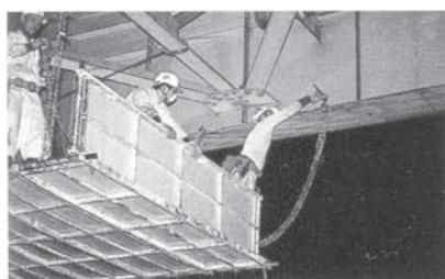
パネルを前方に押し出し、パネルの凹穴に1枚目の「直線・両用連結ジョイント」を差し込みます。次に「脱落防止ピン」を差し込み、「ジョイント固定ボルト」を締め付けます。
