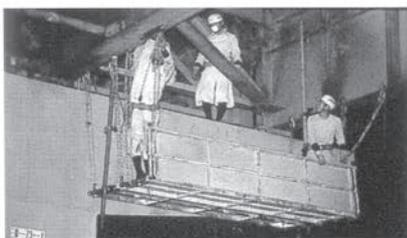
1枚目のSKパネルから2枚目のSKパネル用に、前方約30cm位の所に各主桁下フランジ部に1カ所ずつ計2本のチェーンを取り付けます。取り付けたチェーンに2枚目のパネルを取り付けます。
