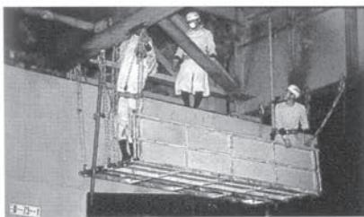
1枚目のSKパネルから2枚目のSKパネル用に、前方約30cm位の所に各主桁下フランジ部に1カ所づつ計2本のチェーンを取り付けます。取り付けたチェーンに2枚目のパネルを取り付けます。
